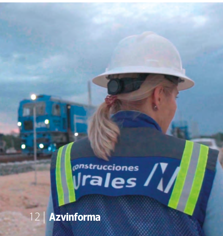
Montaje de vía en el Tramo 3 - Track assembly in Section 3
